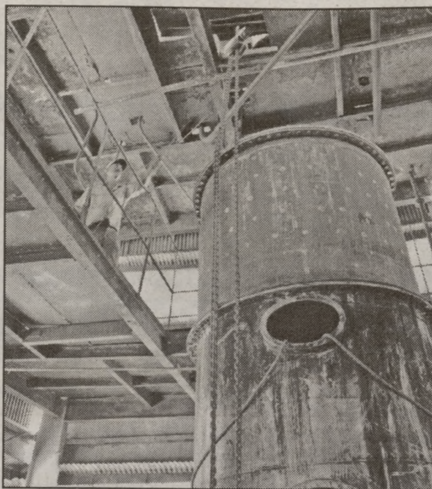
El montaje de una tercera columna para destilar aguardiente resultó una compleja pero necesaria inversión tecnológica.
